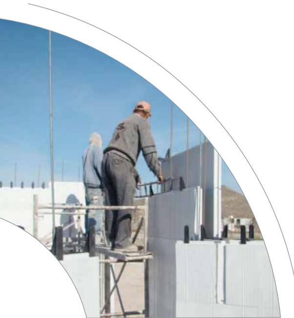
Los premarcos pueden fabricarse de distintas formas, ya sea que se inserten en los paneles **HOLMAK NOVIDESA** o que se coloque por la parte exterior abrazando los paneles. En el primero de los casos no es necesario recortar exactamente los paneles ya que el premarco queda por la parte interior; en la segunda opción si es necesario que se recorte con exactitud el panel ya que el premarco quedará por la parte exterior del panel.
